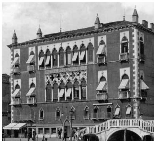
6. Venezia, palazzo Dandolo a San Giovanni Novo (fotografia storica)
