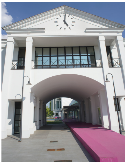
Fig.5 - Bologna, Zona Industriale Roveri, re-insediamento del Fashion Research Italy, per ripartire dalla 'memoria'
