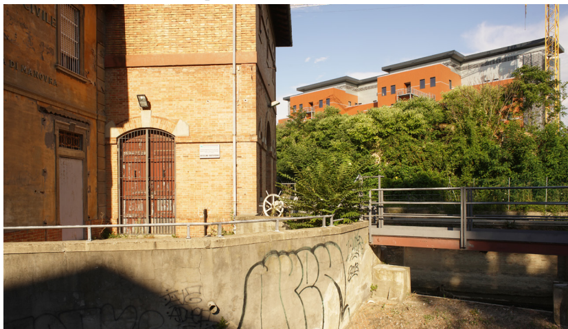
Fig. 2 - Bologna, Quartiere Navile, Polo del Navile UNIBO nell'area proto-industriale del Battiferro che ospita anche il Museo Storico Industriale e il CNR
