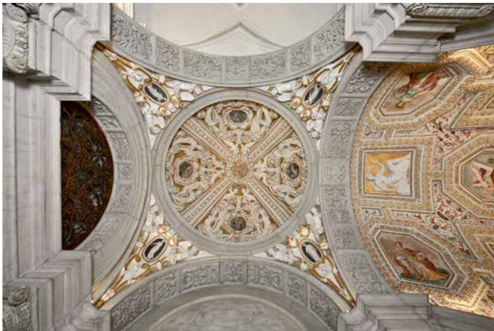
Figg. 9-23: Venezia, Libreria Marciana, dettagli delle volte della scala, 1556-1561.
