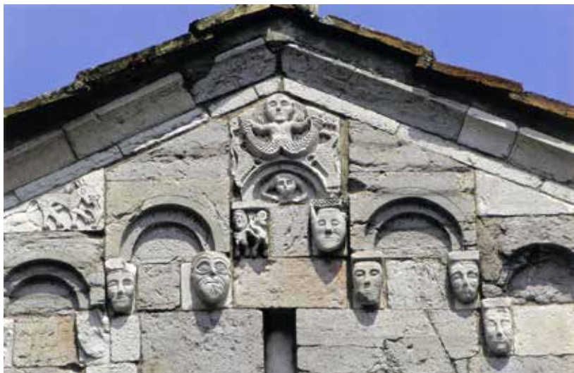
Fig. 22. Maderno, chiesa di Sant'Andrea, facciata, particolare.
