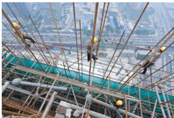
CCTV Headquarters, Pechino, Cina, 2011, progetto di OMA (© Iwan Baan)
