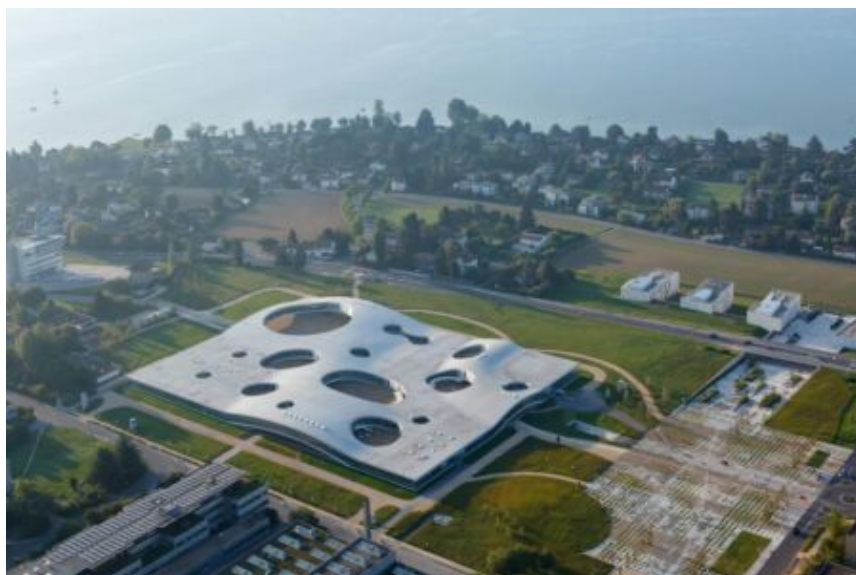
Rolex Learning Center all'École Polytechnique Fédérale (EPFL), Losanna, Svizzera, 2010, Progetto SANAA (© Iwan Baan)
