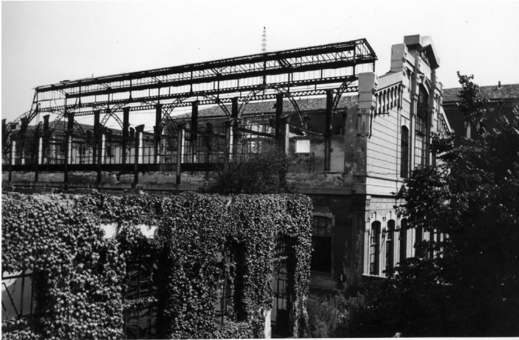
6. Teatro del Popolo , Milano (1943-44; ©Fototeca Archivio Storico Umanitaria, Milano).
