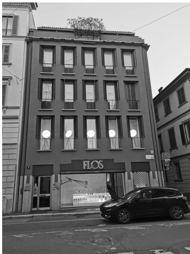
9. Edificio per abitazioni e uffici, Milano, Corso Monforte, 1963-66 (foto Lorenzo Finocchi Gherzi, 2021).
