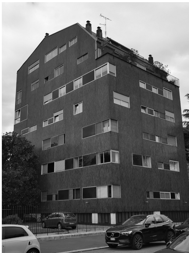
8. Edificio per abitazioni , Milano, piazza dei Carbonari, 1957-61 (foto Lorenzo Finocchi Gherzi, 2021).
